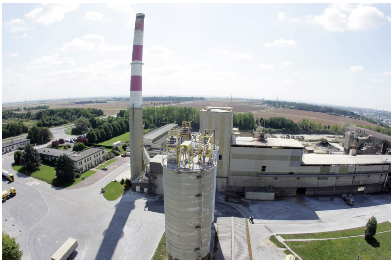
La cimenterie Heidelberg Materials de Ranville
